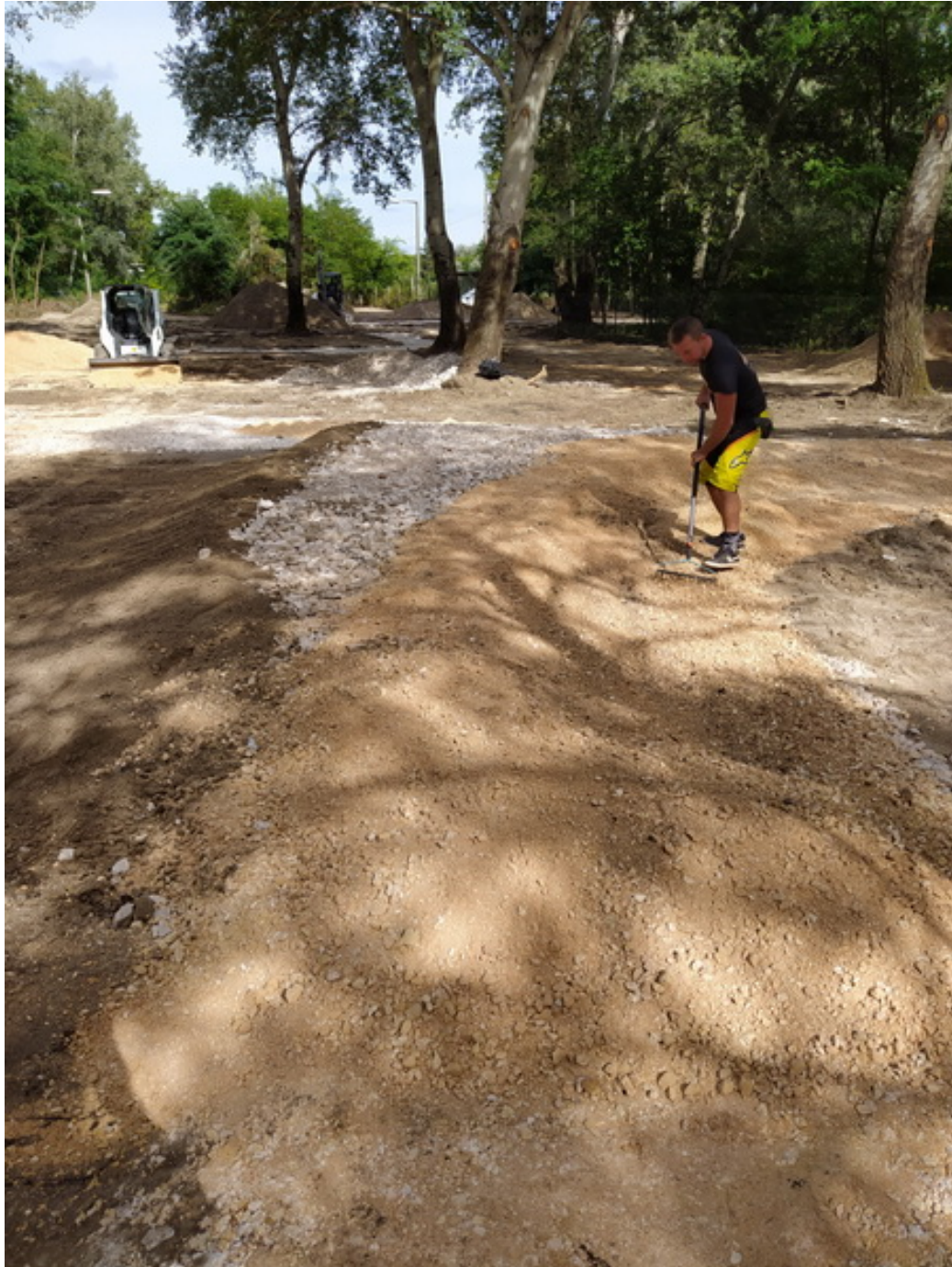
14. ábra: Földmű alépítményének kézi alakítása
