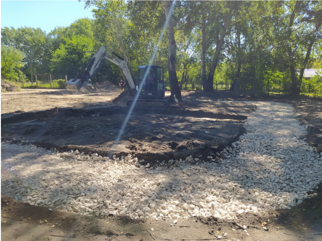
11. ábra: Földmű alépitményének terítése
