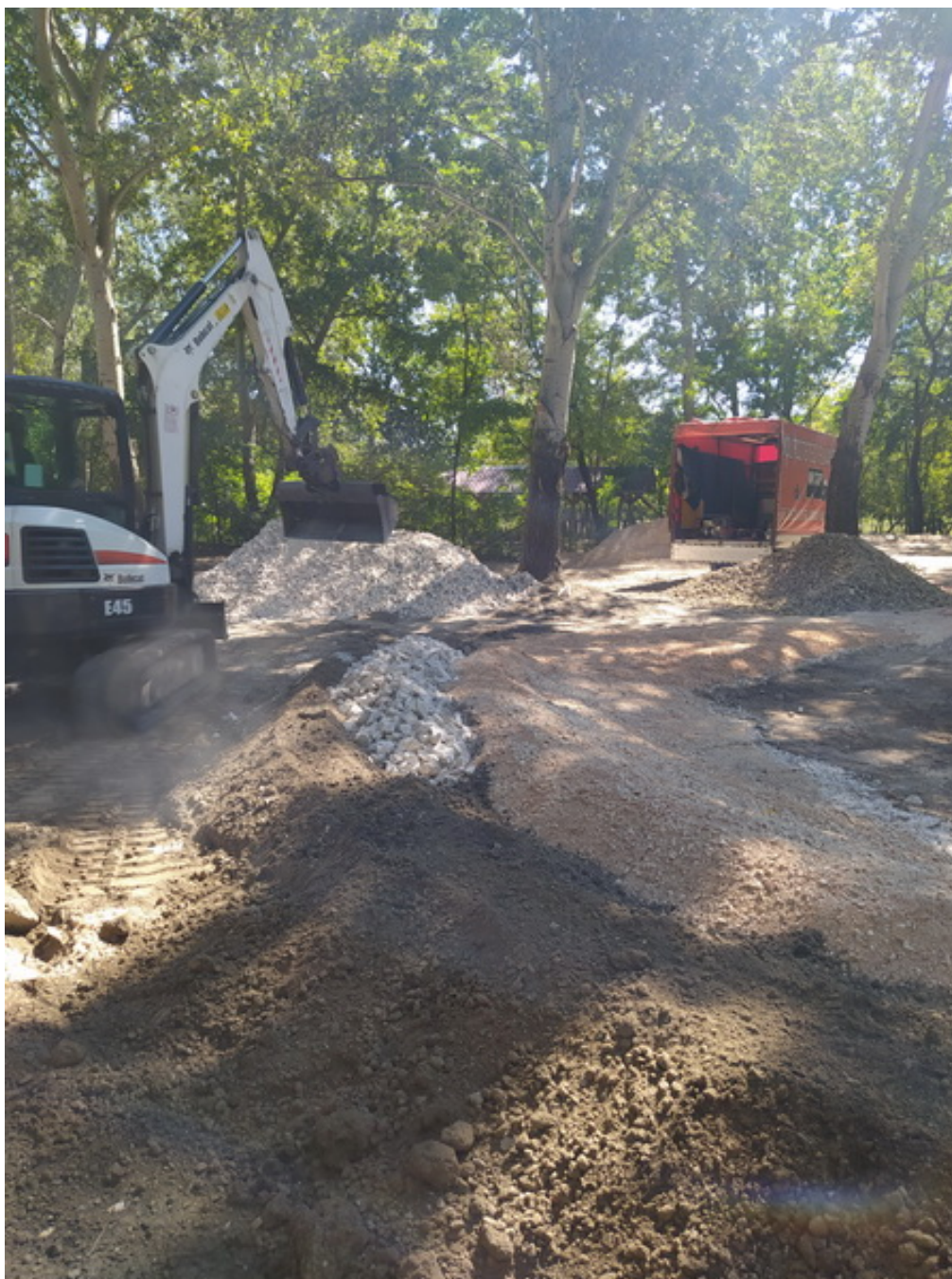
13. ábra: Kialakított ív gépi tömörítés után
