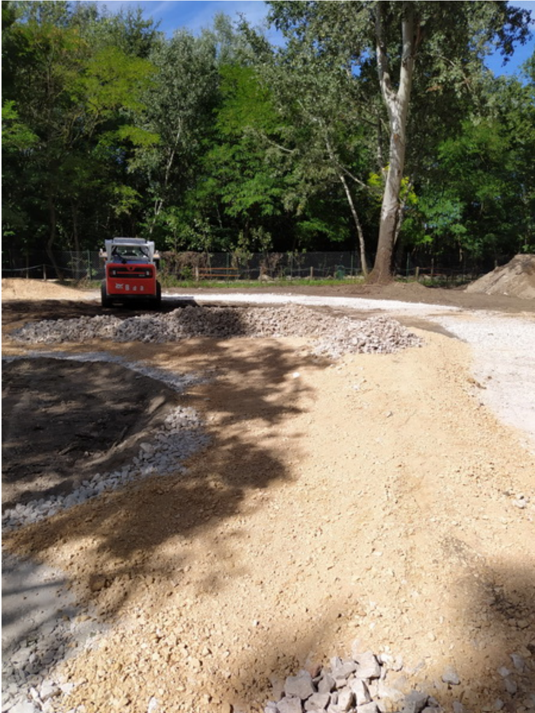
12. ábra: Földmű alépítményének terítése, tömörítése és ív kialakítása
