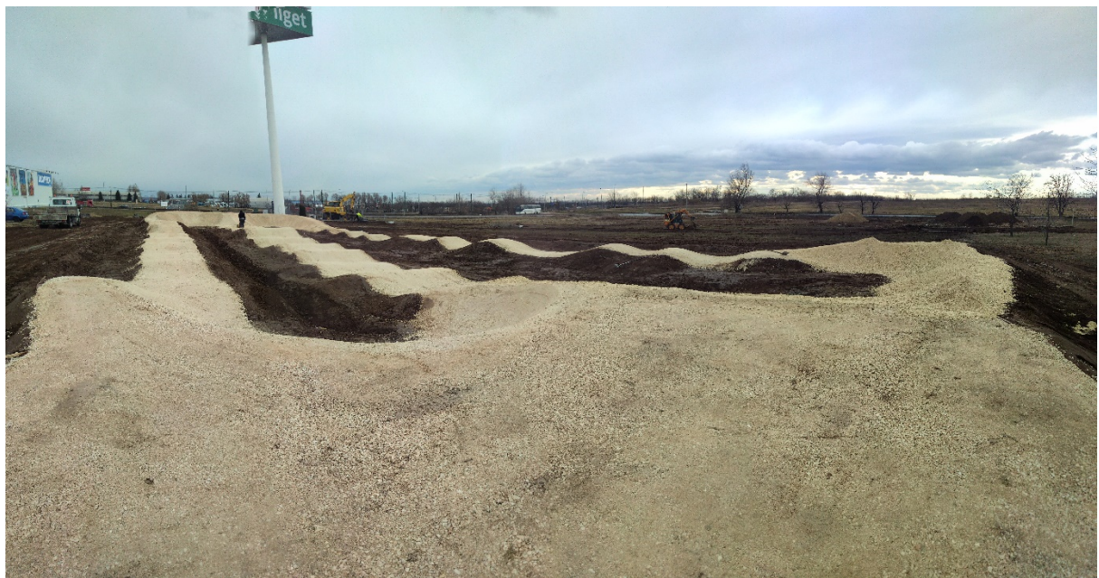
21. ábra: 3. réteg felhordása
