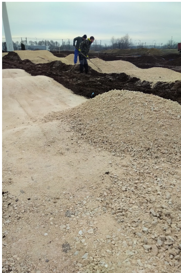
16. ábra: 2. réteg felhordása
