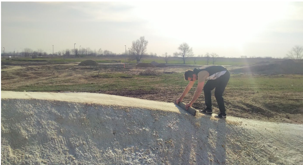
23. ábra: Végző simítás a döngölés előtt
