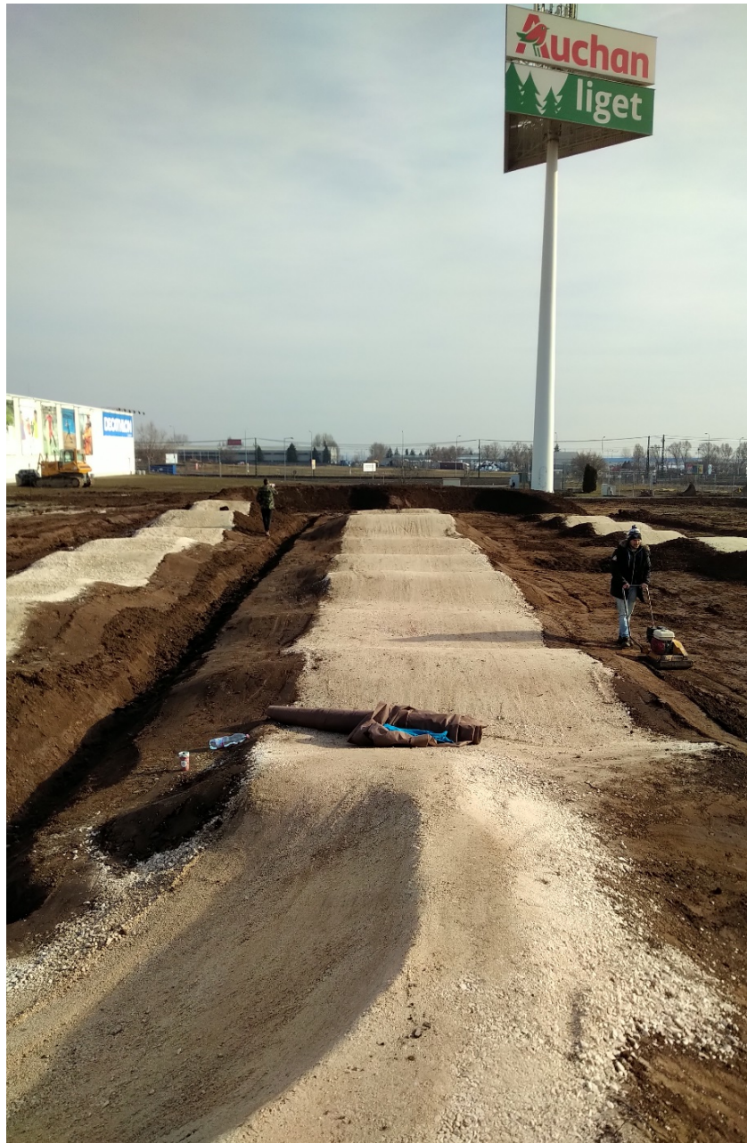
17. ábra: Vízvezetés és az alapréteg dögölése
