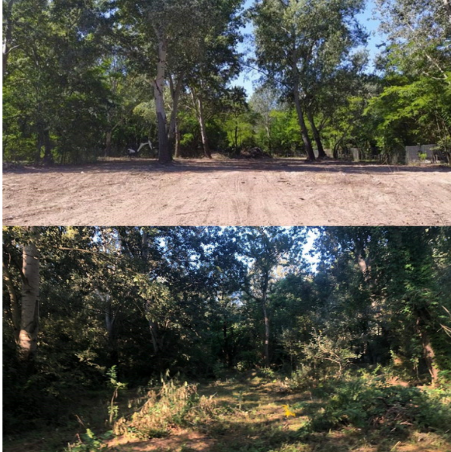
10. ábra: Tükör kialakítása
