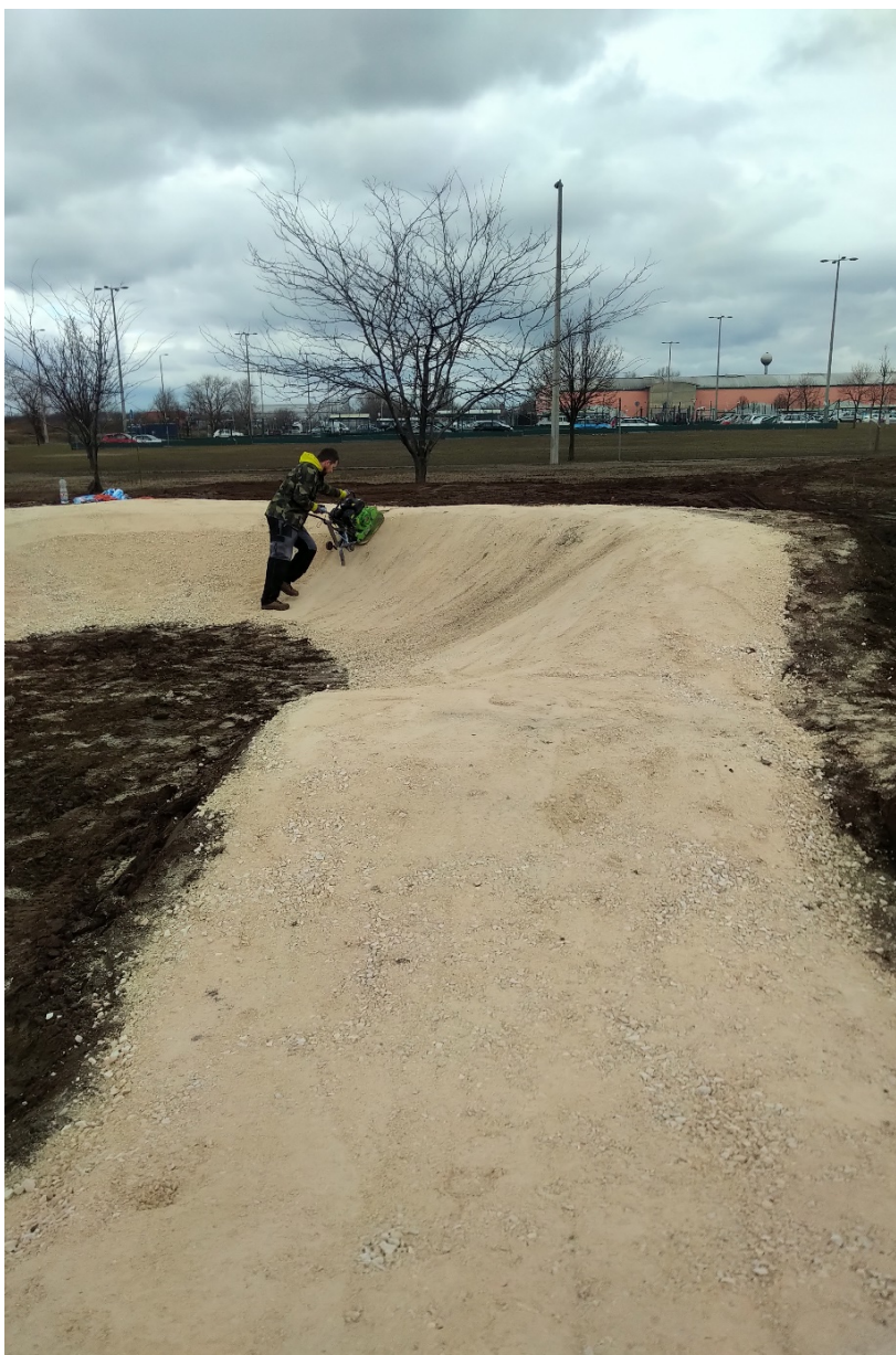
18. ábra: Második réteg tömörítése a kanyarívén
