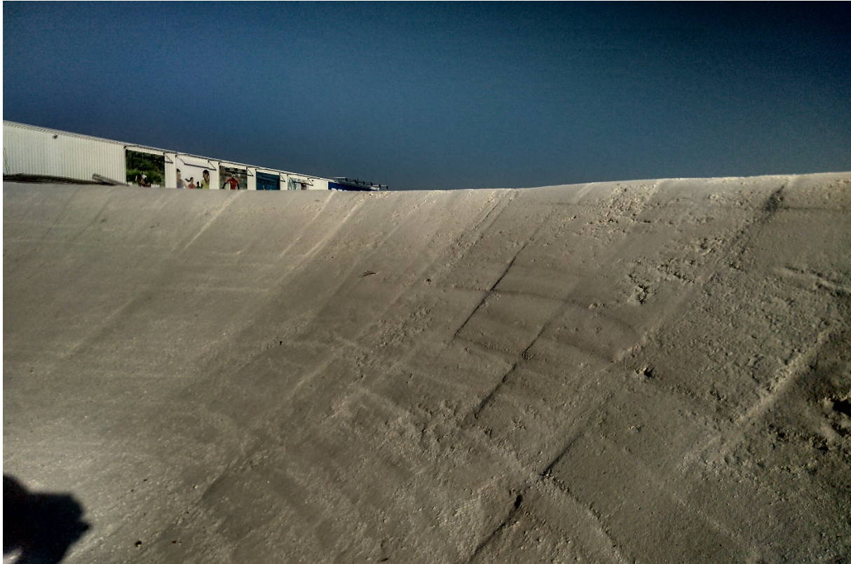
24. ábra: A kész kanyarív beton keménységűre szárad
