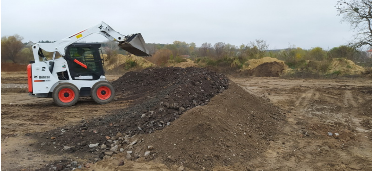
15. ábra: Zúzottkő-alapréteg felhordása
