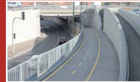
Hauptstraße Nr. 10. - Eisenbahnunterführung
