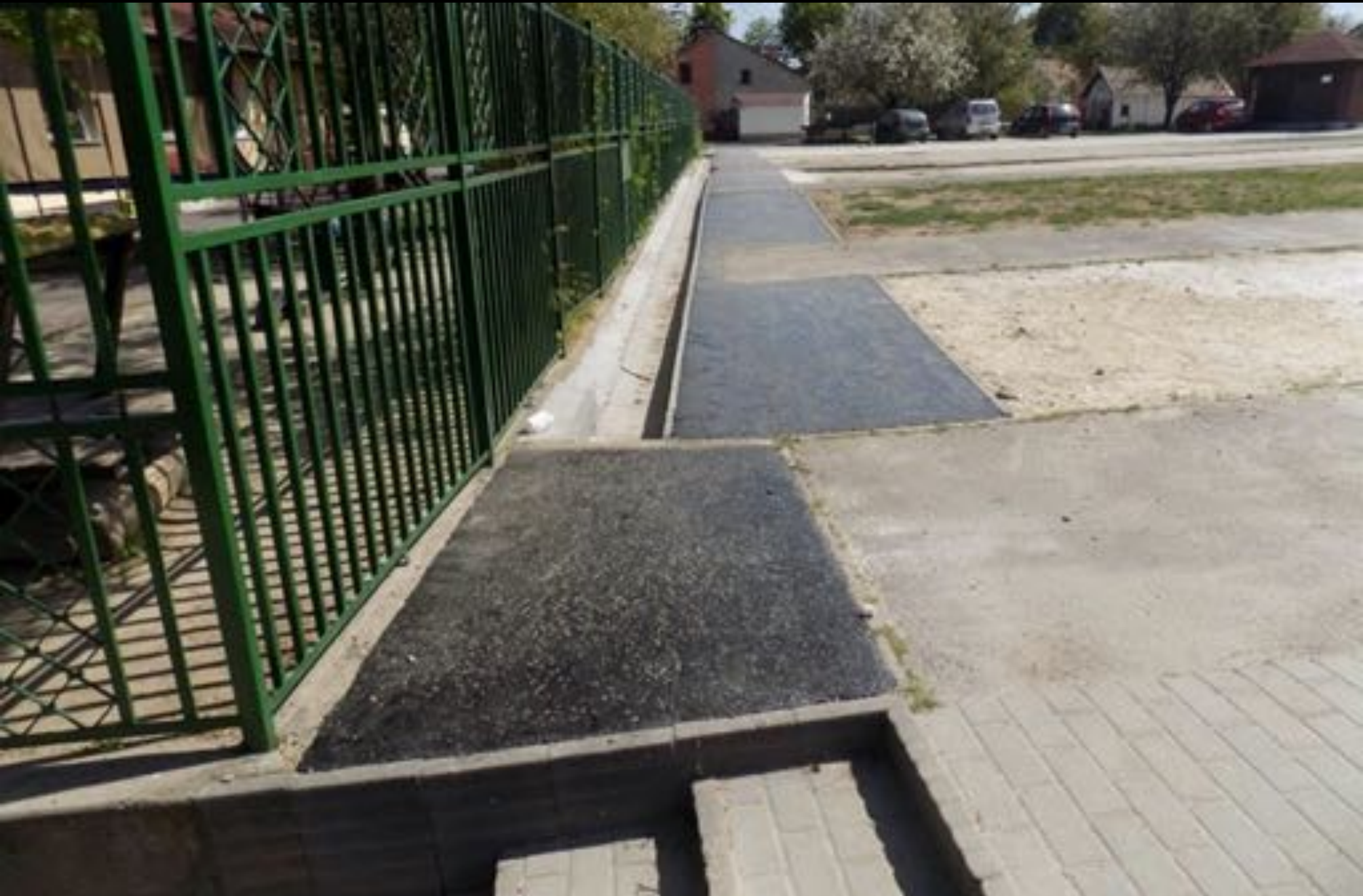
2016.04.21. – Járda a Széchenyi u. óvoda kerítése mellett – 465.254 Ft
