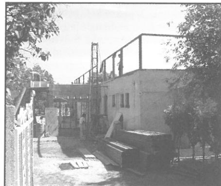
Folyik a Szabadság úti óvoda épületének bővítése
