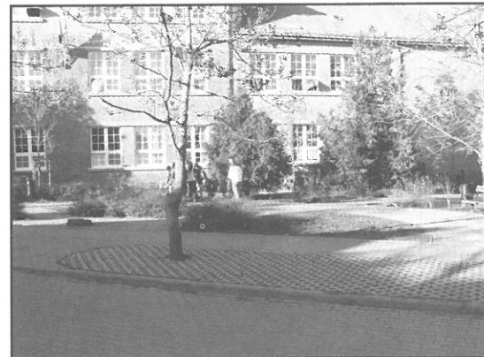
Átépitették a Vásár tér üresen álló ágyásait. A betonrácsok közé fűvet fognak ültetni
