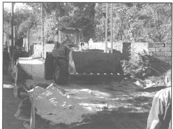
Útépítés a Nagyvárdi utcában 2003 őszén
