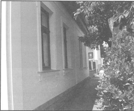
A Tájház felújított utcai homlokzata. Az északi oldalt is újravakolták és újrafestették
