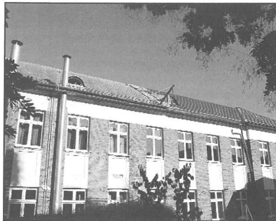
A Templom téri iskola északi épületszárnya: baloldalt a régi palatető, jobboldalt már az új cseréptető látszik
