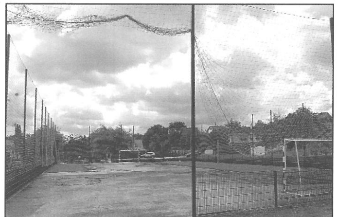
Megkezdték a sportpálya aszfaltozását is
