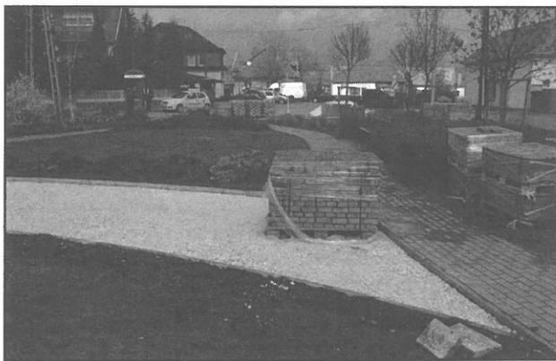
Járda- és parkolóépítés a Hősök terén 2008 májusában
