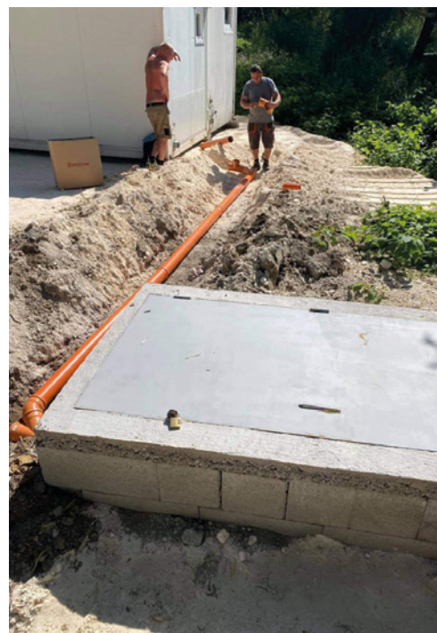
A mosdókonténerek csatornanyomvonalát és gépészetét a városgazdák építették ki
